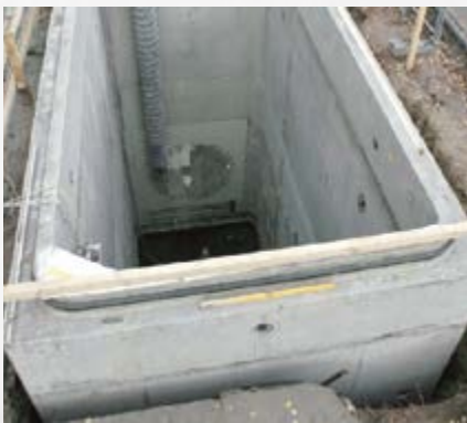
Стартовий шахтний стовбур для мікротунелювання
