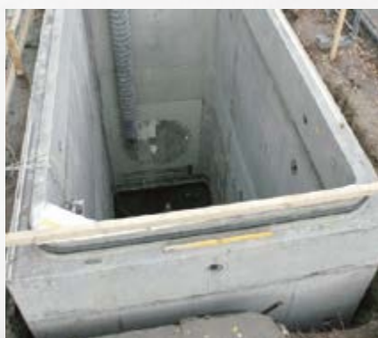
Стартовий шахтний стовбур для мікротунелювання
