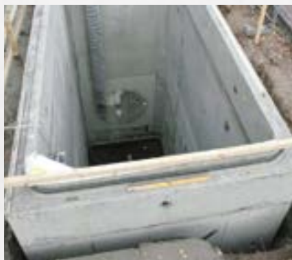
Стартовий шахтний стовбур для мікротунелювання
