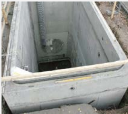
Стартовий шахтний стовбур для мікротунелювання
