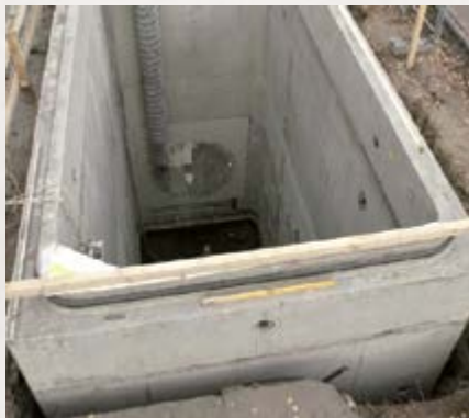
Стартовий шахтний стовбур для мікротунелювання
