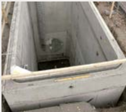
Стартовий шахтний стовбур для мікротунелювання
