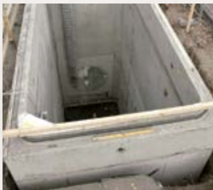
Стартовий шахтний ствол для мікротунелювання
