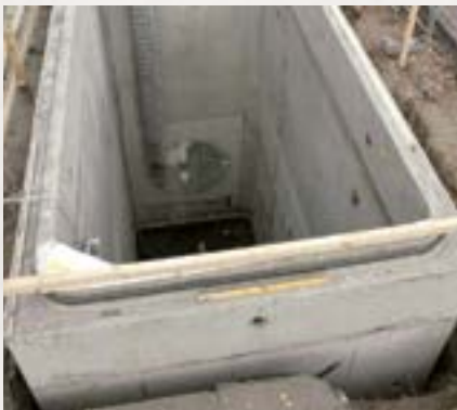
Стартовий шахтний ствол для мікротунелювання
