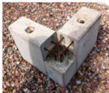
Рис. 2. Вузол з'єднання стінових панелей.
