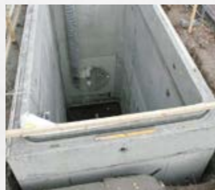
Стартовий шахтний ствол для мікротунелювання
