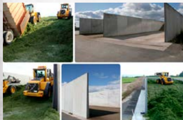
Плоский силос висотою 4 метри розрахований для транспорту до 25 т.
