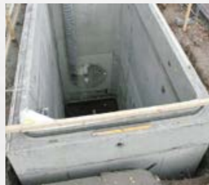
Стартовий шахтний ствол для мікротунелювання
