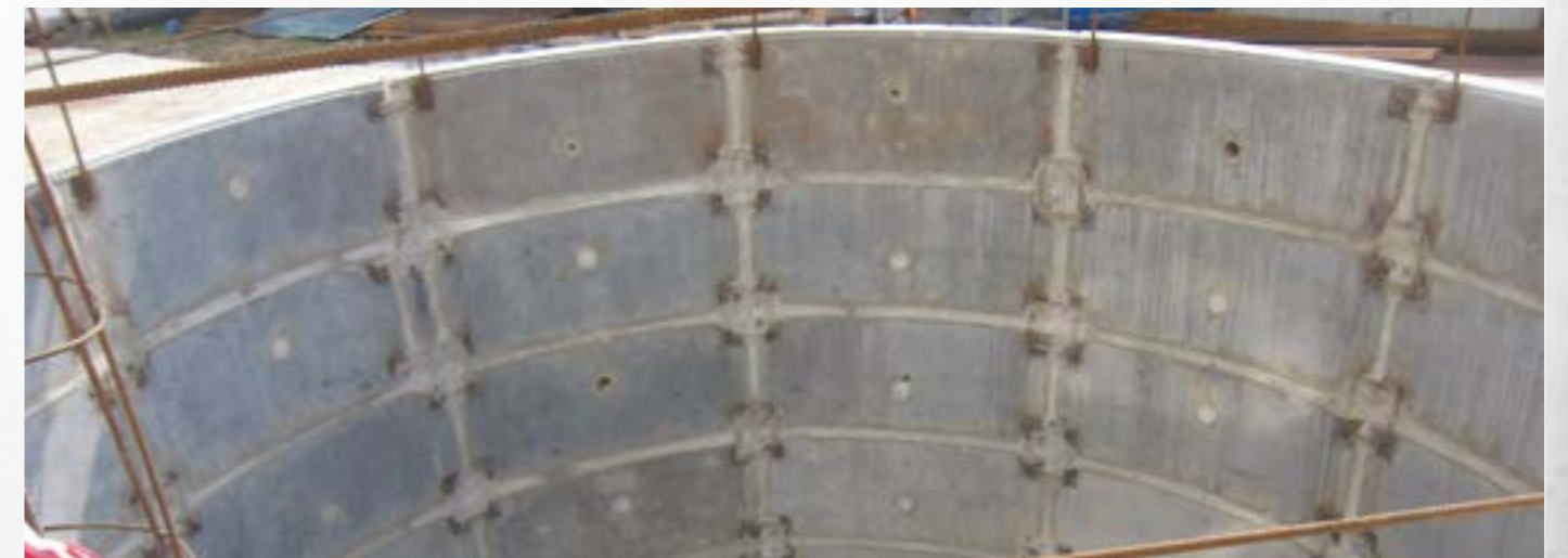
Будівництво каналізаційного колектору методом шпательового проходження, м. Київ
