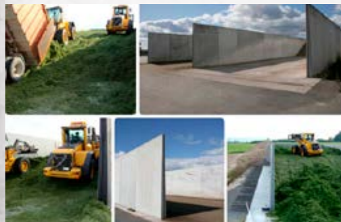
Плоский силос висотою 4 метри розрахований для транспорту до 25 т.
