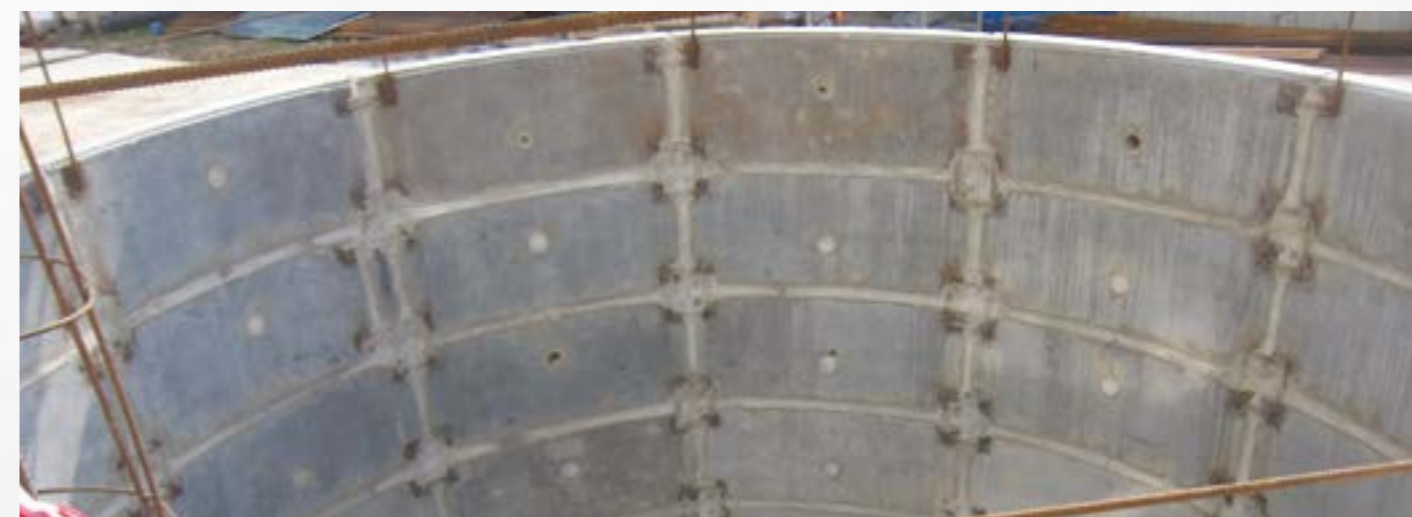
Будівництво каналізаційного колектору методом шпательового проходження, м. Київ
