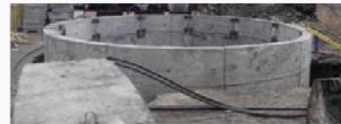
Будівництво каналізаційного колектору методом шпательового проходження, м. Київ
