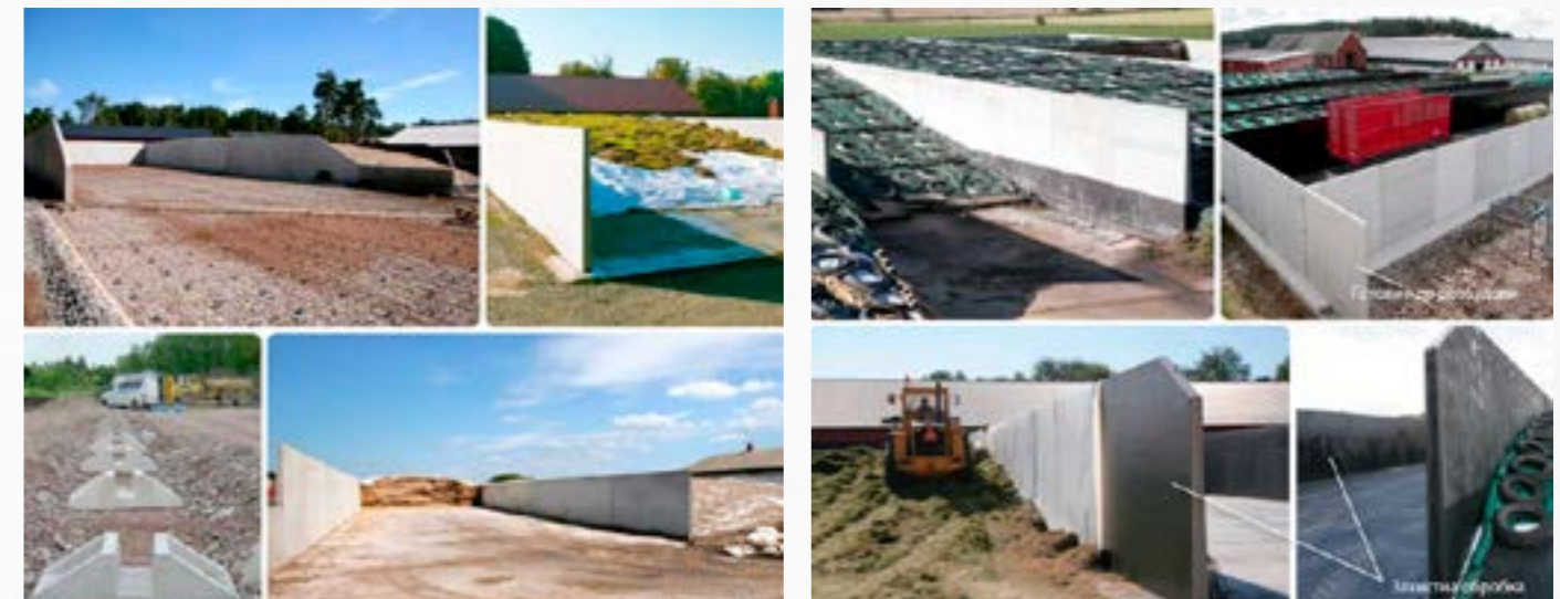
Плоский силос має внутршню висоту 2,4 метри та розрахований на ущільнюючий транспорт вагою до 15 тон.
